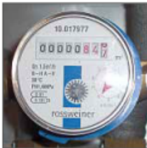
Kaltwasserzähler zur Erfassung des Wasserverbrauchs.
